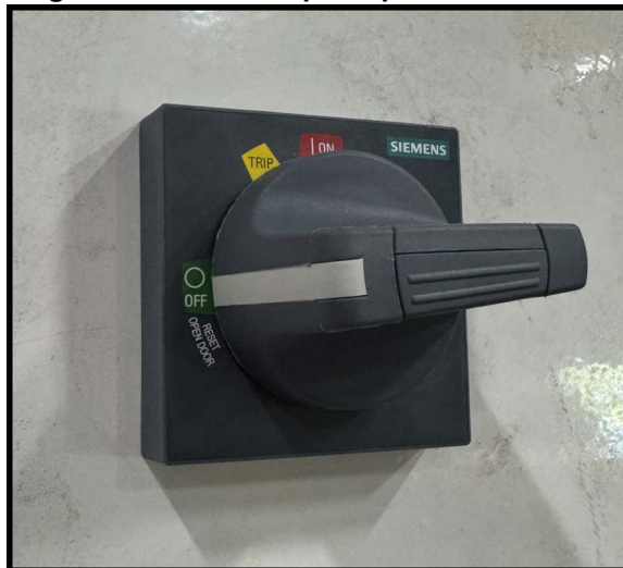
Figura 2-1: El gabinete eléctrico principal
