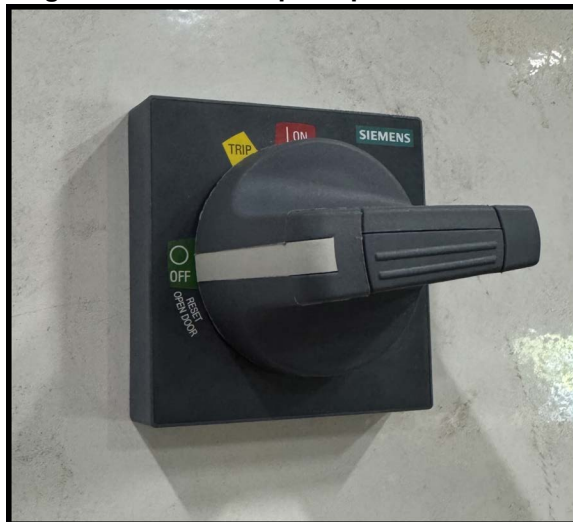
Figura 2-1: El gabinete eléctrico principal
