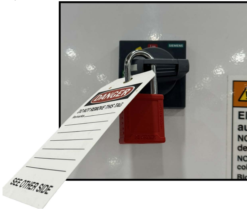
Figura 2-2: Mecanismo de bloqueo/etiquetado en un gabinete eléctrico principal
