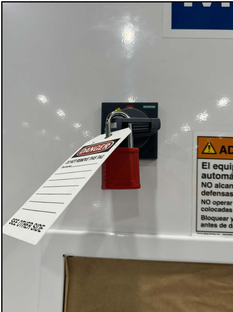
Figura 2-2: Mecanismo de bloqueo/etiquetado en un gabinete eléctrico principal
