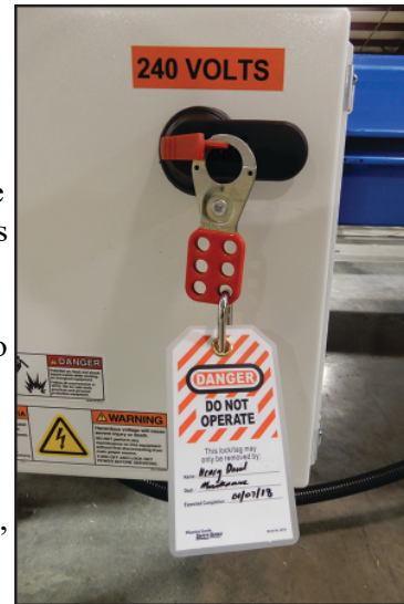
Figura 1-1: Ejemplo de un dispositivo de bloqueo/ etiquetado
