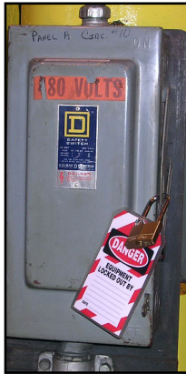
Figura SEGURIDAD-1: Ejemplo de un mecanismo de Bloqueo/Etiquetado en un panel de fuente de alimentación
