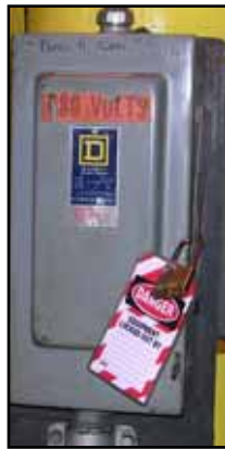
Figura 5-2: Bloqueo/Etiquetado del panel de fuente de alimentación
